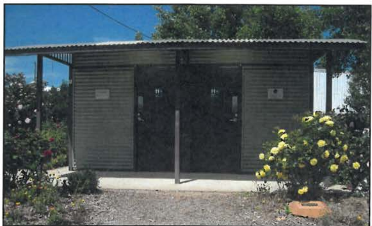
Kiamma Creek toilet amenities
