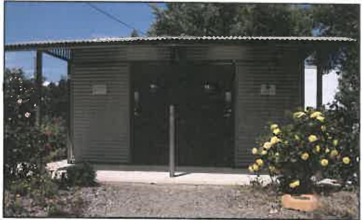
Kiamma Creek toilet amenities
