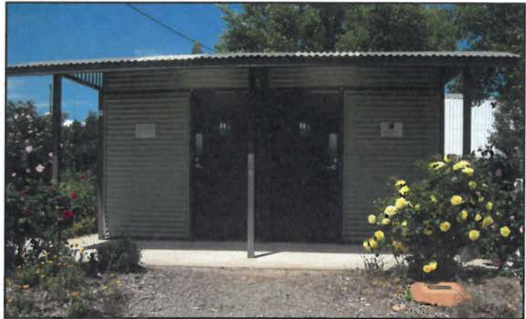
Kiamma Creek toilet amenities
